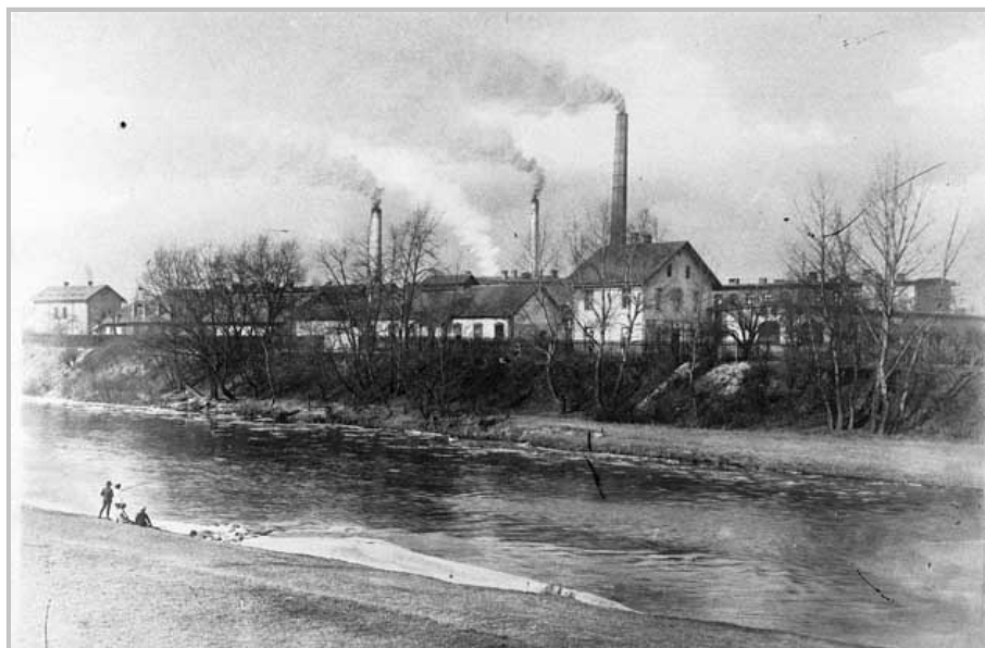
Mendlova továrna - pohled od jihu pře řeku Ohři
