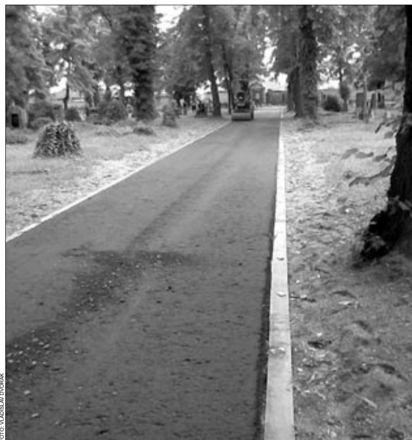
Finální úpravu povrchu prováděla firma pojezdovým válcem.
