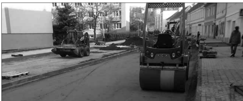
V závěru roku se dokončila rekonstrukce Hájkovy ulice.
