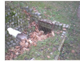
Zatrubněný výtok před zánulším vodoteče do kanálu bez informací o původu vody
