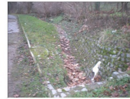
Suché žlabové koryto na konci otevřené vodoteče
